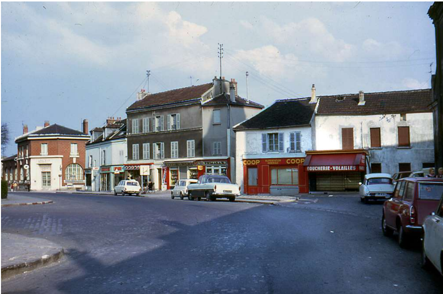
Entre église et bureau de poste vers 1969.
