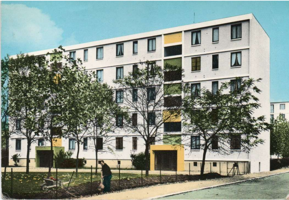
Un bâtiment de la Cité de l'Espace vert vers 1964. Au premier plan, M. Marciaux creuse une tranchée pour planter une haie de troènes. (carte postale P.I., collection de l'auteur).
